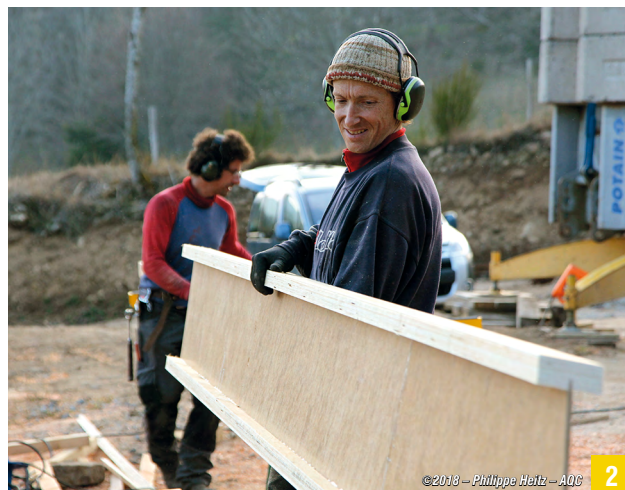
▲ 1 Toiture-terrasse en poutres en I fixées par connecteurs métalliques. Membrures bois massif aboutés et âme OSB. 2 À performances mécaniques égales, une poutre en I est trois fois plus légère qu'en bois massif.
