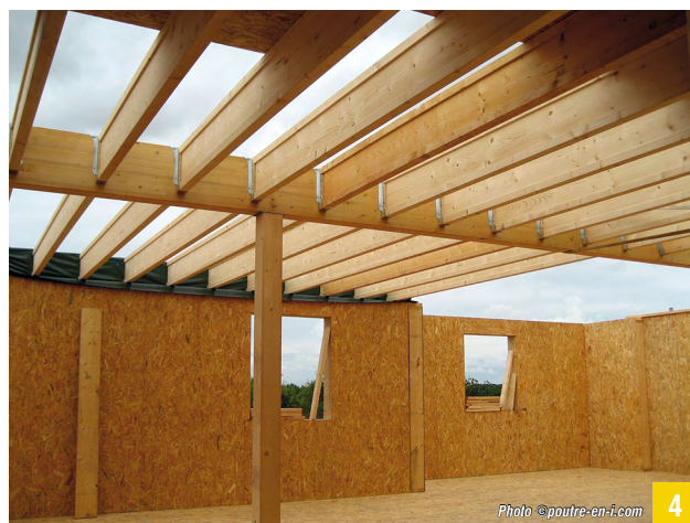
▲ 1 Toiture-terrasse en poutres en I fixées par connecteurs métalliques. Membrures bois massif aboutés et âme OSB. 2 À performances mécaniques égales, une poutre en I est trois fois plus légère qu'en bois massif.
